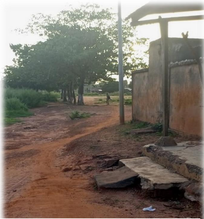
Photo 1 : Rue à paver de Bérégadougou (Rue A au PK0 +100)
