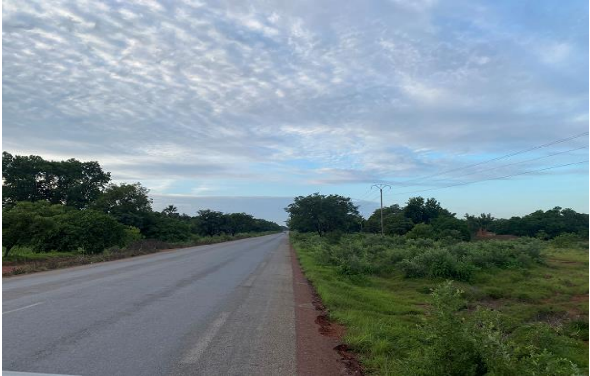
FIGURE 2 : VUES DE LA ROUTE BANFORA – FRONTIERE COTE D’IVOIRE
